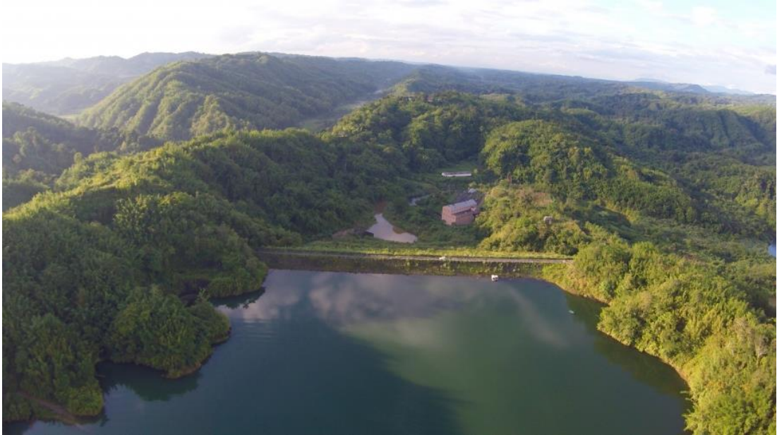
Photo: Serlui B HEP (12 MW)
