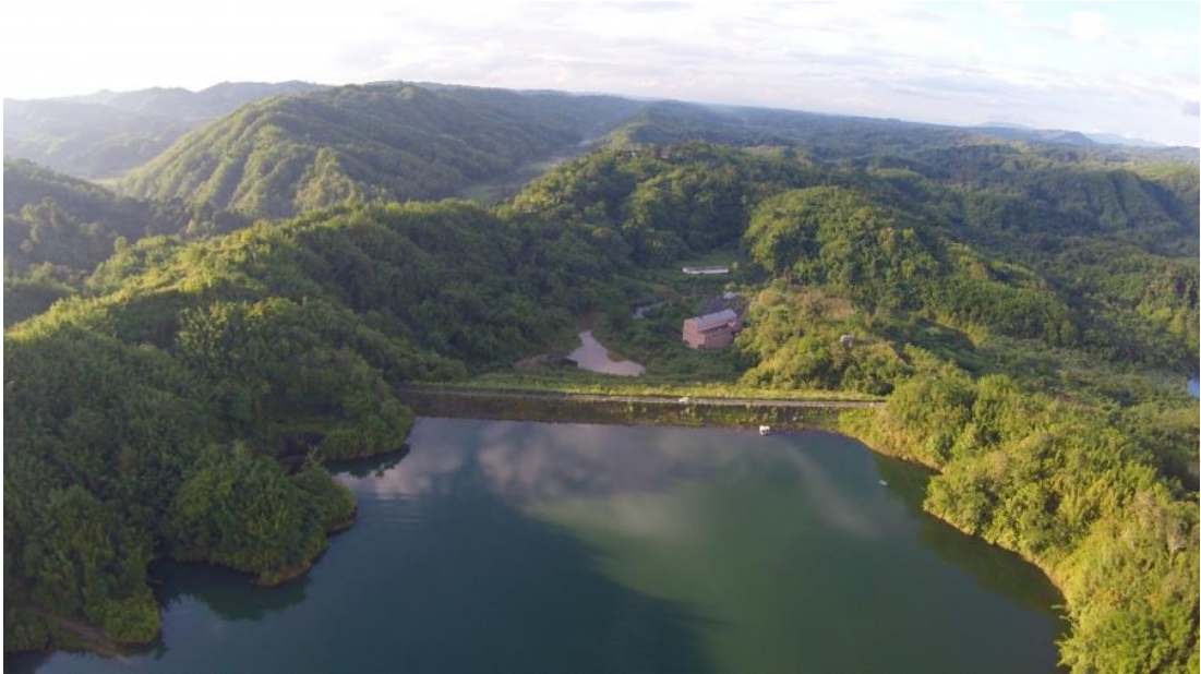
Photo: Serlui B HEP (12 MW)
