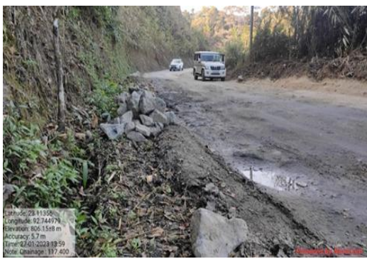
(d) Chainage 15 km
